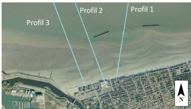
Illustration 44: Position des trois profils de plage utilisés pour les calculs de débits de franchissement pour la digue-promenade de Malo-les-Bains (Étude de détermination de l'aléa submersion marine intégrant les conséquences du changement climatique en région Nord-Pas-de-Calais, 2013).
