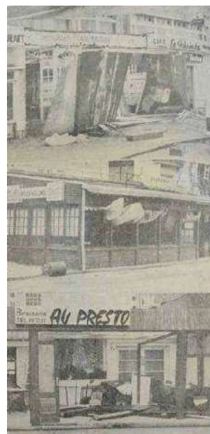
Figure 2: Terrasses et vitrines des magasins du front de mer endommagées.
