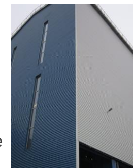
Enceinte de confinement du four à arcs électriques (doghouse)
